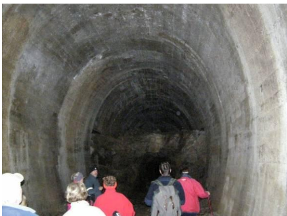
Tunel-proti koncu se konča z bunkerjem in je dobro betoniran.
