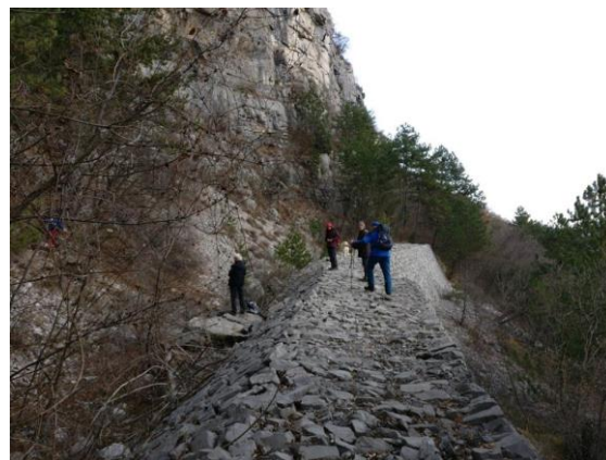
Debel kamniti zid ščiti železniško progo.
