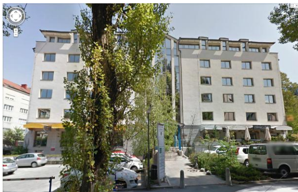
Poslovna stavba na Zarnikovi ul.3 v Ljubljani, kjer je potekal letošnji občni zbor.
