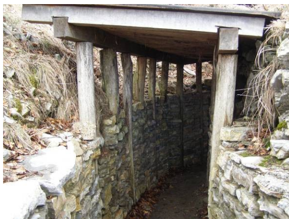
Detajli obnovljenega rova.
